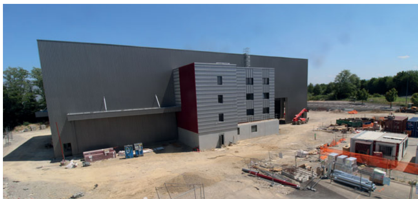
Le bâtiment brut avec la zone de bureau et salle de contrôle à l'avant (état d'avancement en août 2022)
