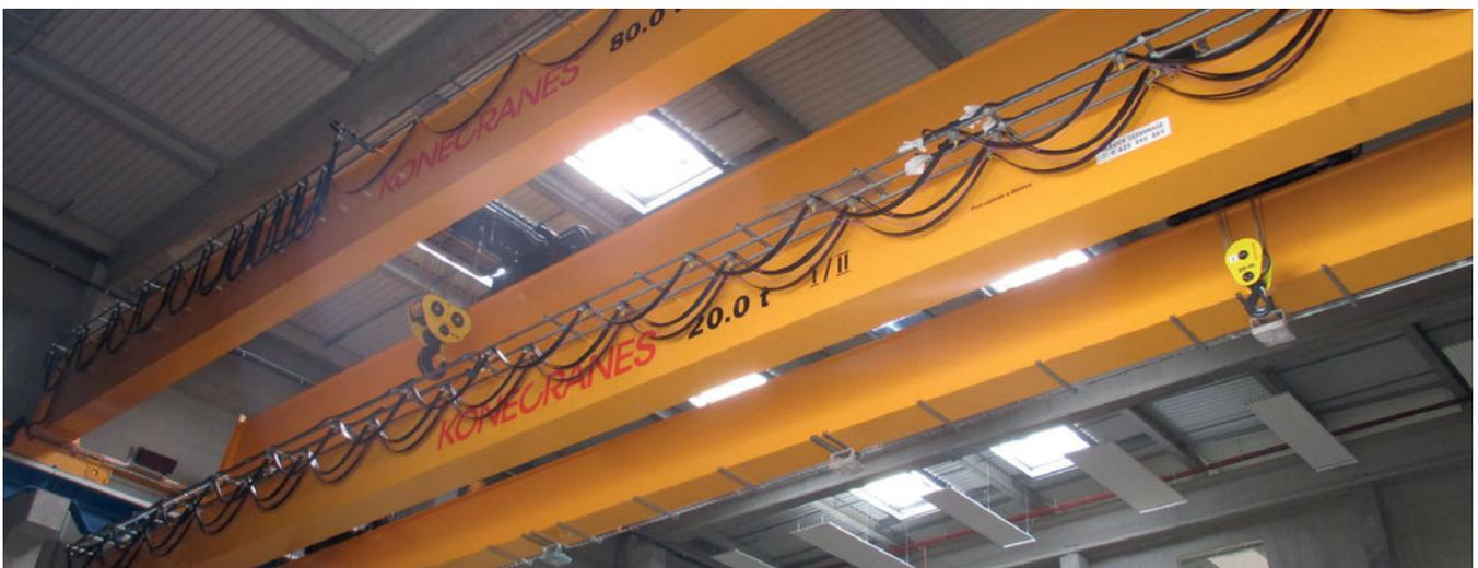
Les 4 ponts roulants ont été livrés et installés au mois de mars. Chacun des 2 halls est équipé d'un pont de 80 tonnes et d'un pont de 20 tonnes.
